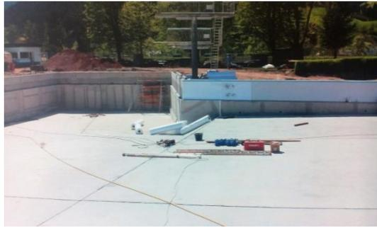
Rings ums Becken werden **Gräben** gegraben für die **Rohre**, durch die später das aufbereitete Wasser wieder ins Becken gepumpt wird. Die Öffnungen für die Einströmdüsen werden durch die bestehende Beckenwand gebohrt.
