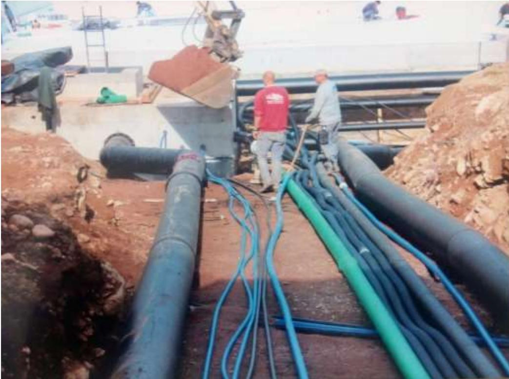
neue dicke Verrohrung für die geforderte Becken-Durchströmung
