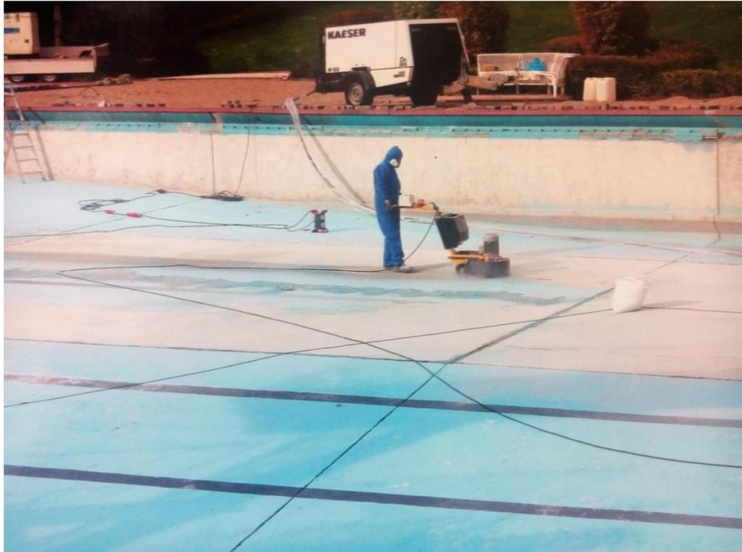
Betonsanierung, Farbe abschleifen, Fugenmaterial entfernen (Altlasten)
