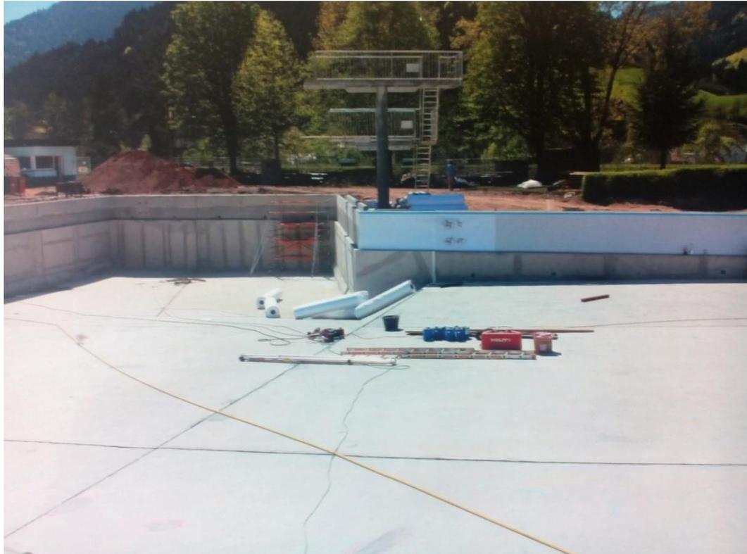
Auskleidung mit Folie, kurze Bauzeit
