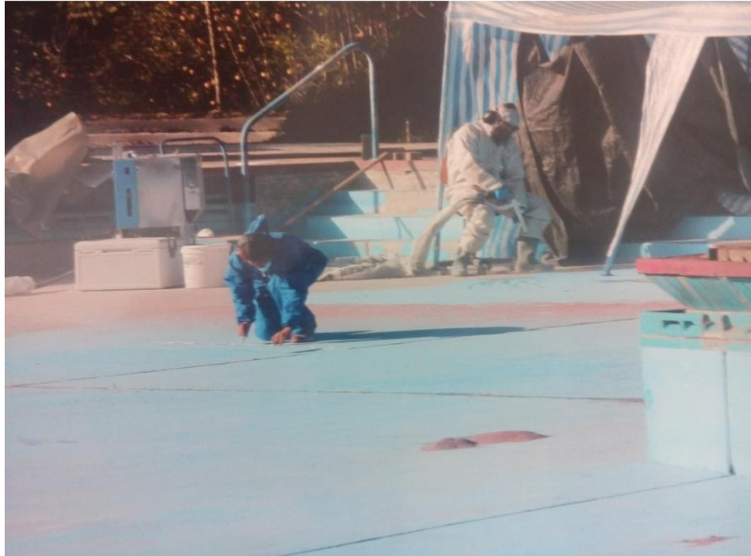
Betonsanierung, Fugenmaterial entfernen (Altlasten)
